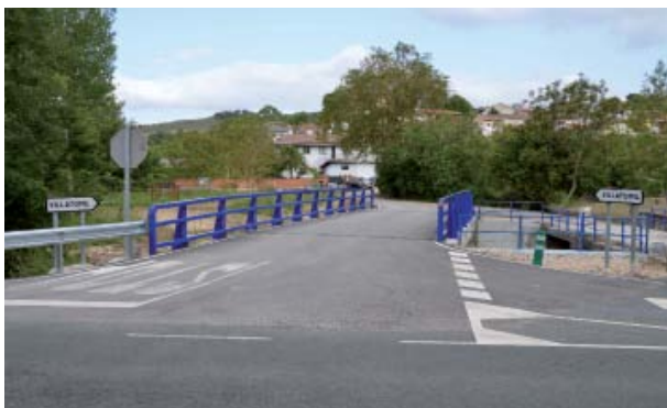
El puente de Villatomil es una de las obras que se han llevado a cabo estos últimos años
